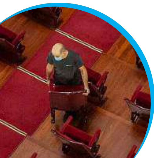
Operario retirando butacas.
